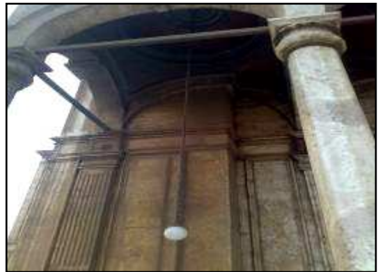
صورة رقم ( 1 ) تبين تغير لون سطح الحجر نتيجة لترسب الملوثات الجوية وذرات الكربون والسناج ( جامع محمد علي باشا بالقلعة من الناحية الشمالية الشرقية من الخارج )
