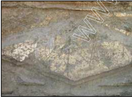
صورة رقم ( 2 ) تبين ترسب الغبار و الاتربة و الملوثات الجوية علي سطح الحجر ، مما أدى الي طمس معالم الحجر وتآكل الاجزاء البارزة منه ( الناحية الجنوبية الشرقية من الخارج )
